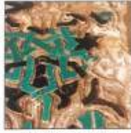
Çiçi Mosaic Paneli Sahib-ı Ala Türbesi Restorasyon çalışmaları zile edilmiştir.
